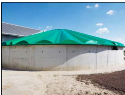
Jeden z dwóch nowych reaktorów oczyszczalni ścieków w Wólce Kosowskiej
