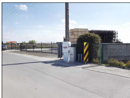
Podolszyn ul. Polna. Przepompownia ścieków i fragment odtworzonej ulicy
