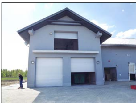
Nowy budynek technologiczny oczyszczalni w Wólce Kosowskiej
