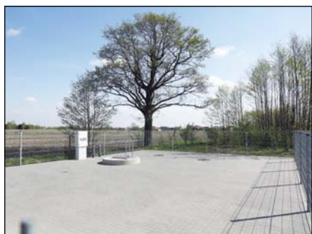
Przepompownia ścieków w Janczewicach
