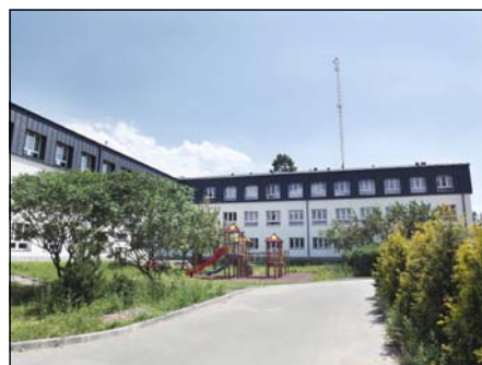
Dzięki nadbudowie szkoła powiększy się o 505 m 2
