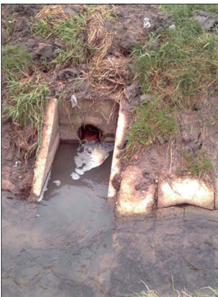
Oczyszczony wylot zbieracza melioracyjnego
