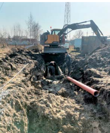
Budowa kanalizacji w Stefanowie
