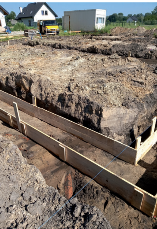
Budowa domu na drenach
