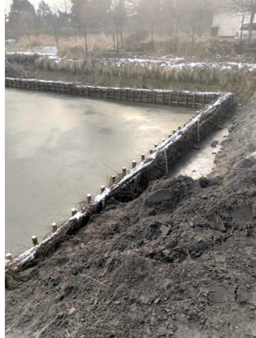
Renowacja zbiornika wodnego w Łazach
