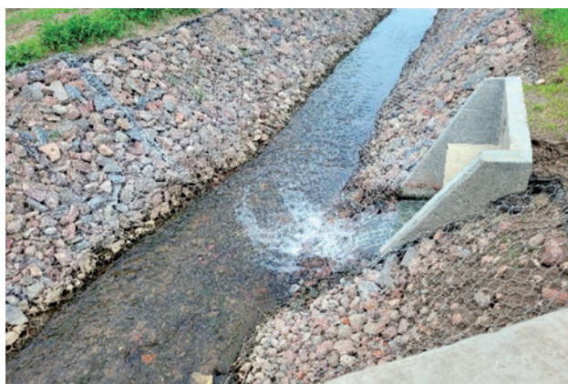
Wylot ścieków oczyszczonych z oczyszczalni „Zamienie”
