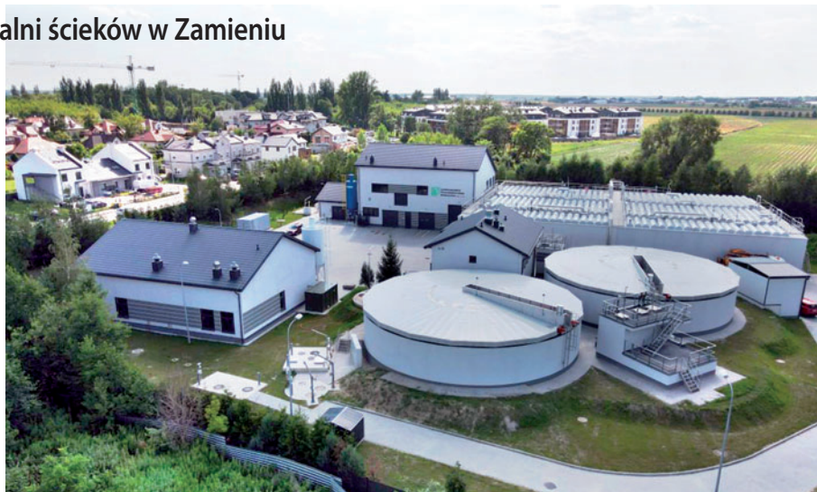
Obiekt oczyszczalni ścieków
