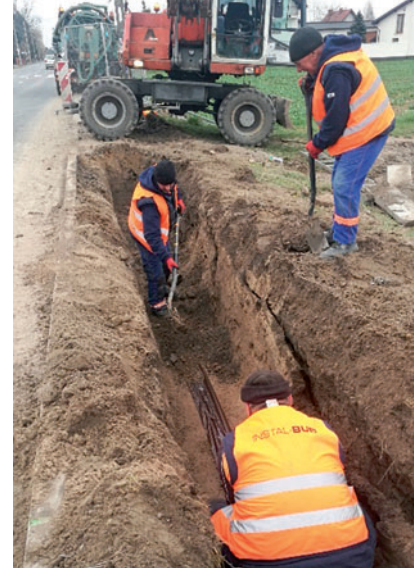
Budowa kanalizacji sanitarnej tłocznej
