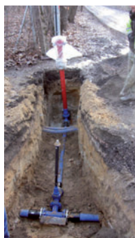
Budowa sieci wodociągowej w ul. Ogrodowej w Stefanowie – hydrant i sieć wodociągowa z urządzeniami
