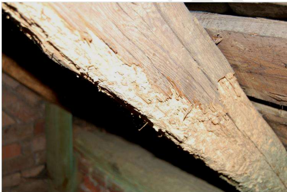
fot. 2. Żerowisko spuszczela pospolitego.
