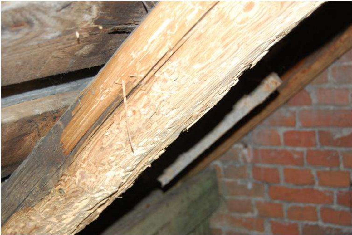
fot. 5. Żerowiska spuszczela pospolitego w krokwi.
