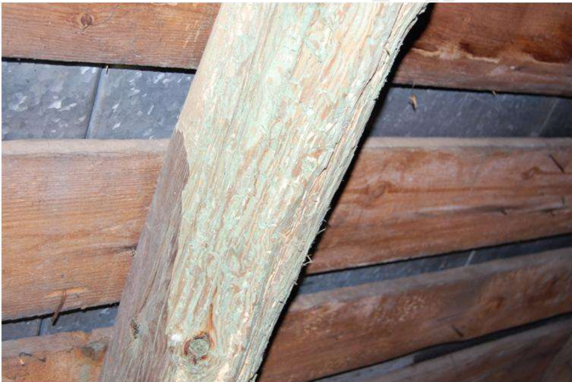
fot. 4. Krokiew z żerowiskami spuszczela pospolitego.
