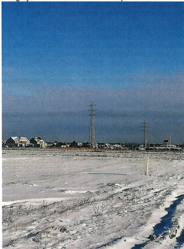
Rys. Linia elektroenergetyczna 110 kV na obszarze opracowania.
