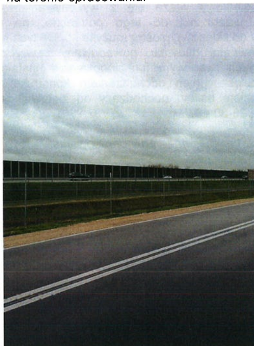
Rys. Droga ekspresowa S7 na terenie opracowania.
