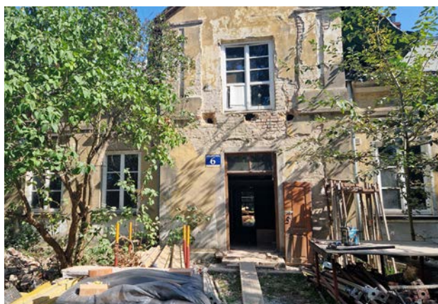
W trakcie remontu.
