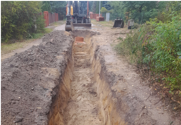
Budowa sieci wodociągowej w Stefanowie.
