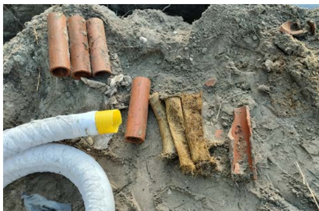
Naprawa zapchanych rur drenarskich w Woli Mrokowskiej.
