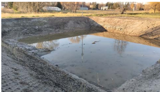
Staw w Mrokowie po wykonaniu prac.
